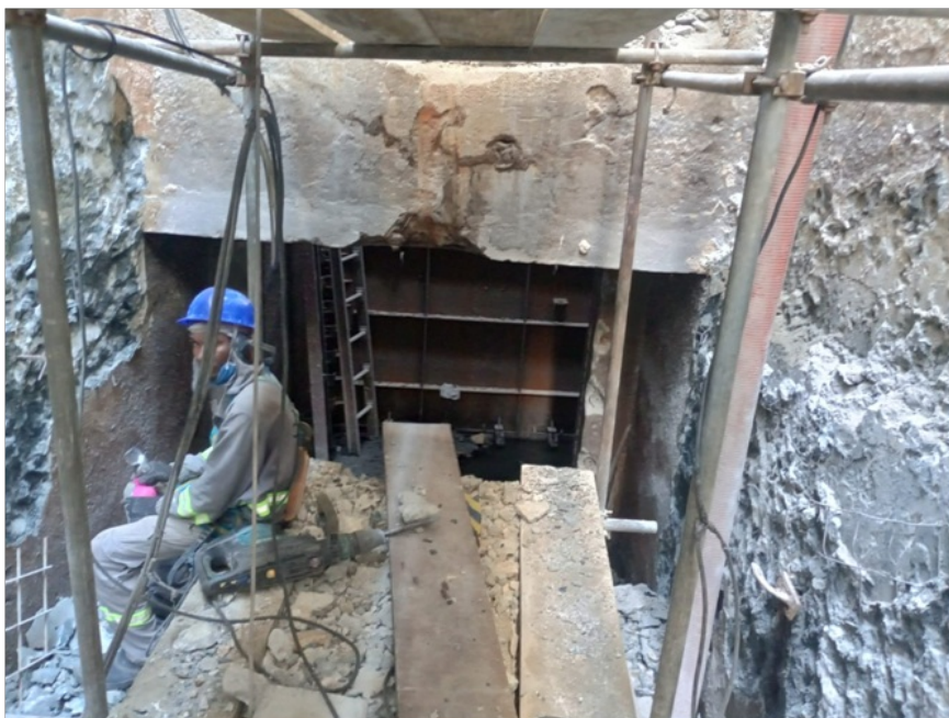
Foto 3 – Vista das comportas colocadas para execução do poço 4
