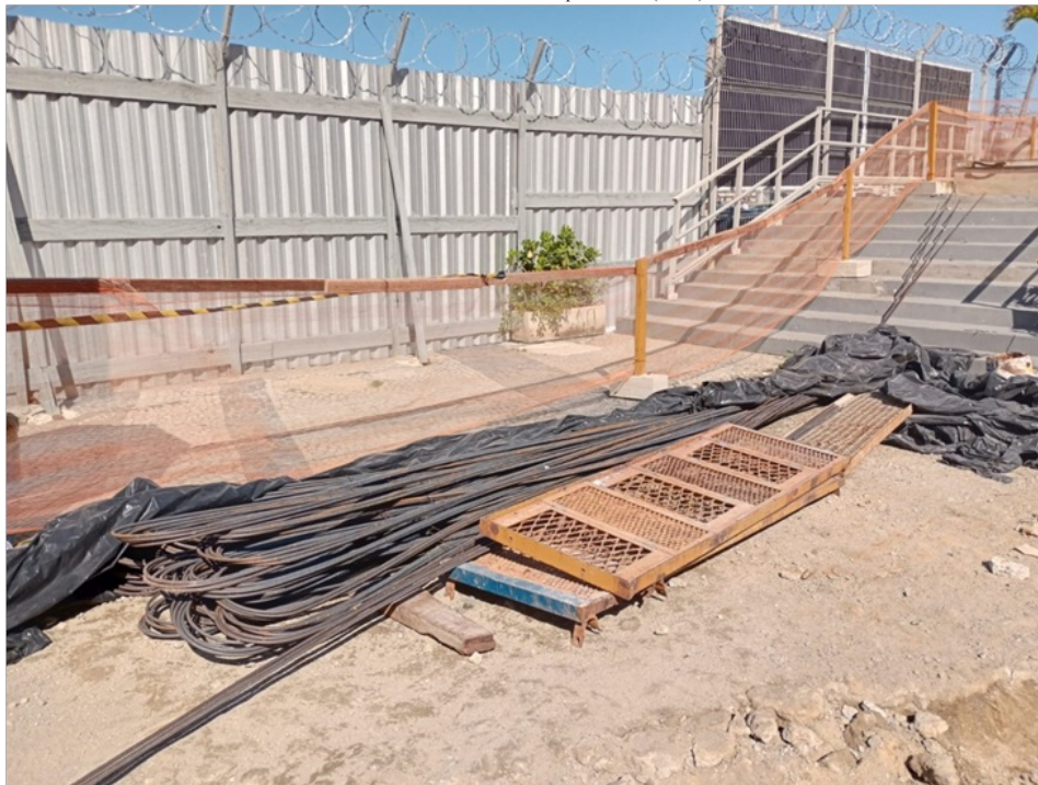
Foto 6 – Vista interna do canteiro : tapume, passarela com cerca para transito de operários.
