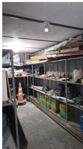
Foto 9 e 10 – Vista do escritório e do almoxarifado.
