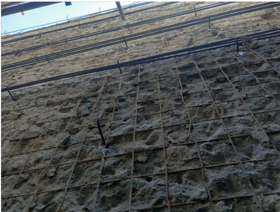
Foto 5 – Nova armadura sendo posicionada (acima)
