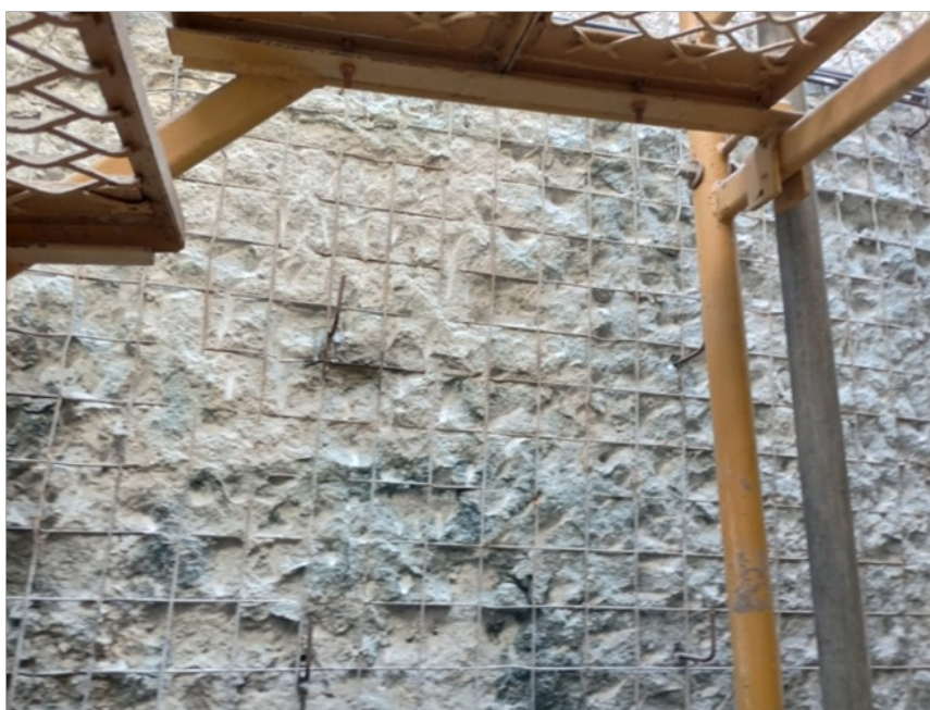
Foto 4 – Vista da parede apicoada
